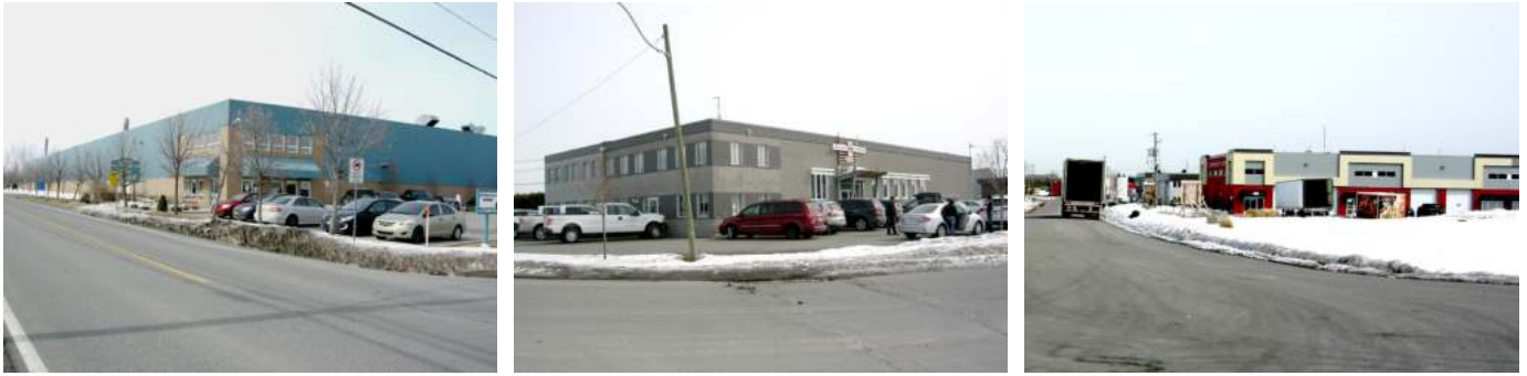
FIGURE 3. Bâtiments du parc industriel de Saint-Eustache
